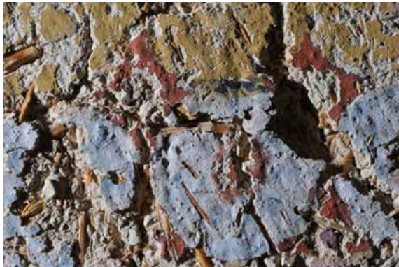
図7 浸食されたような傷み Fig.7 Damages of erosion
