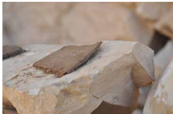
図33 収縮による剥離
